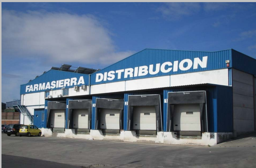
IMAGEN DE LA FACHADA DE LA NAVE
